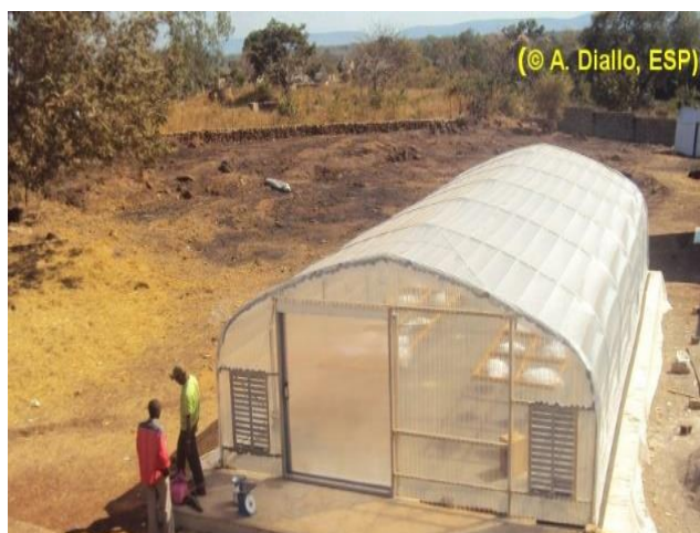
Figure 3 - Séchage du fonio en serre
